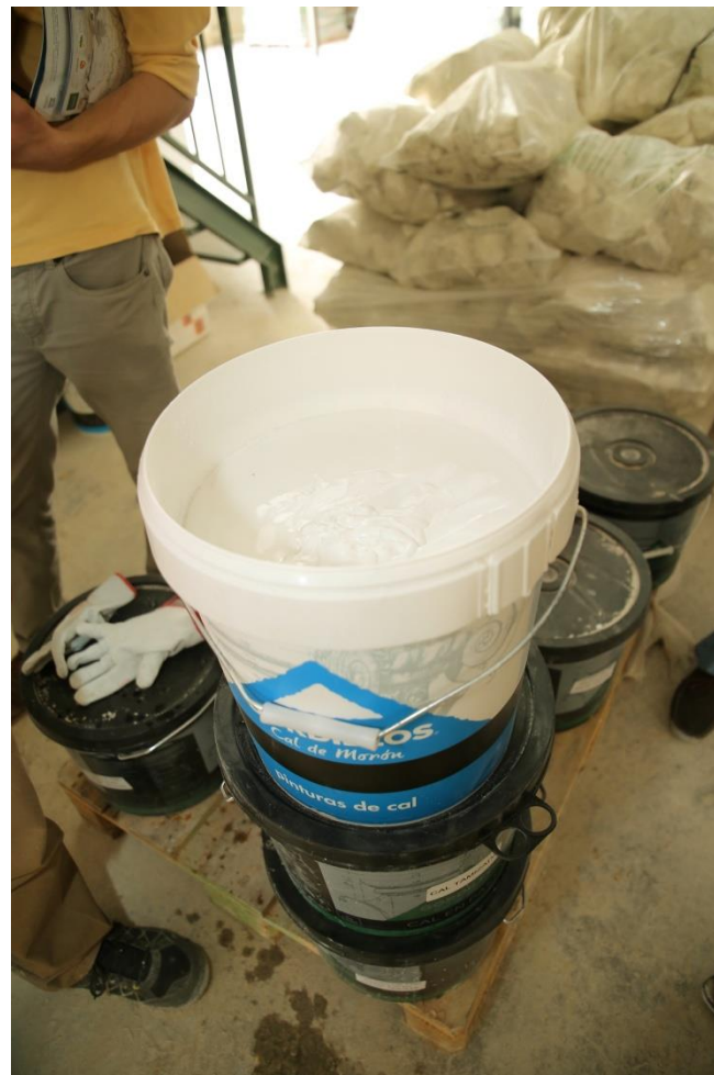
Processo de extinção da cal viva em cal em pasta em Móron
